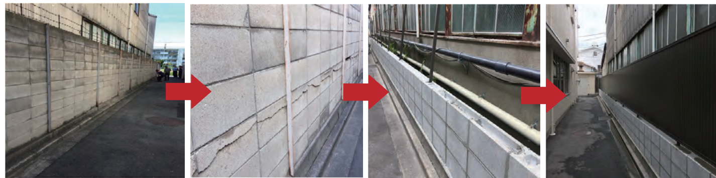
①改修前のブロック塀 ②ひび割れの状態 ③撤去後、3段ブロック新設 ④その上にフェンスを設置
