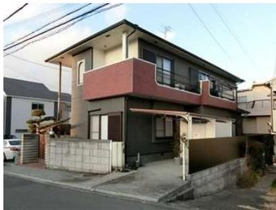
この3枚の写真は、完成後の住まいの様子。3方囲まれたブロック塀は撤去してフェンスを設置しました。地震や台風が来ても、もう倒壊の心配はありません。重たい瓦屋根は軽い屋根に置き替え、モルタル壁をめくりサイディングに。ダークグレーのサイディングで、住まいの雰囲気が変わり、モダンな佇まいになりました。
