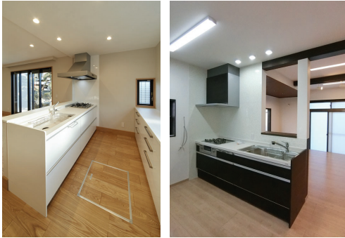
キッチン施工の事例です☞
