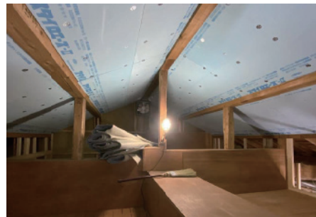
▲屋根断熱とすることで屋根裏のロフト空間を有効活用
