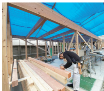
▲建方工事完了
