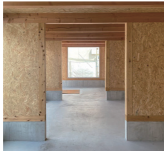
▲内装工事完了
