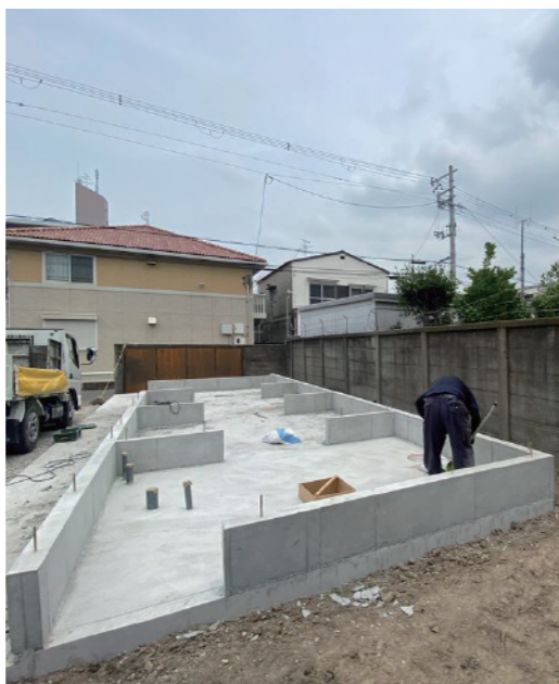
▲基礎工事完了
