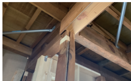
▲既存の弱い部分を金物や新たな材で補強していく。
