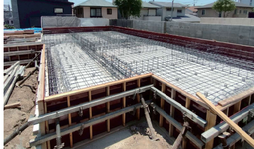
▲ 密な基礎配筋によるべた基礎
