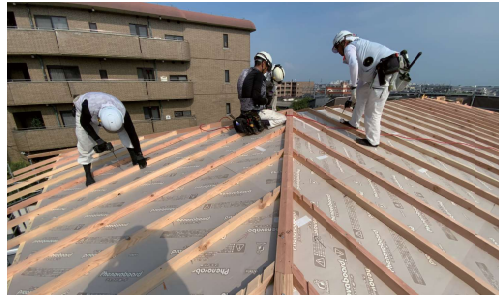
▲ 晴天の棟上げ、全員総出の屋根断熱施工の様子
