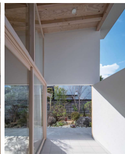
▲ 半屋外の玄関ポーチ
